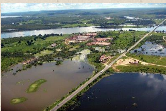
Danos ocasionados por enchentes
